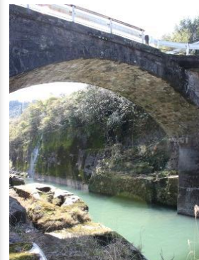
春明の石橋 佐々川本流に架かるアーチ橋。 長方形に切り出した石材を 水平に積み上げている。 吉井、世知原にはたくさんの 石橋が点在する。
